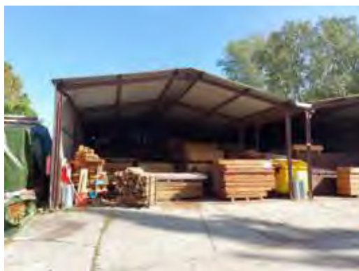
Ocelový sklad dřeva st. 1264/14
