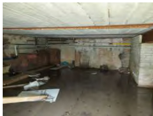
Technický suterén podl bývalou kotelnou
