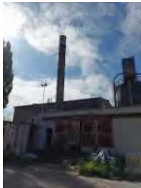
Roztřískovač kusového odpadu parc.č. st. 1264/4
