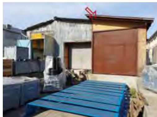
Přístavba k Přístřešku
