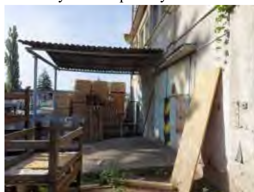
Přístřešek nad nádrží
