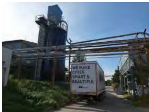
Teplovodní potrubí
