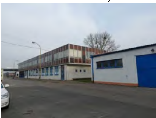
Administrativní budova a Skladovací hala strojů
