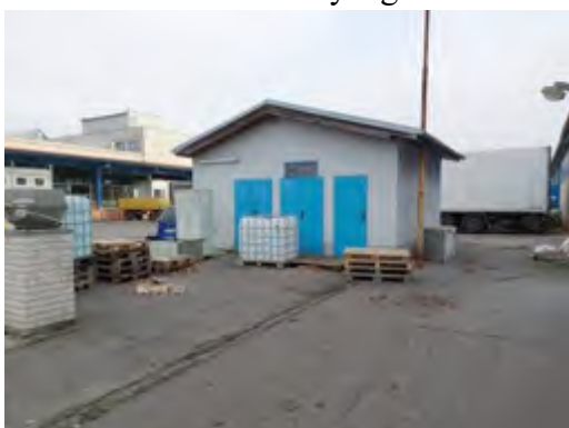
Objekt s kanceláří a elektrorozvodnou
