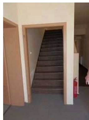
schodiště do 2 NP - podkroví
