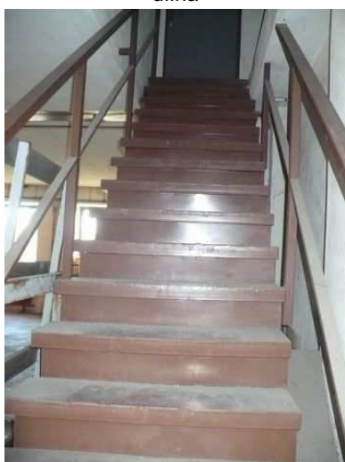
schodiště do meziskladu
