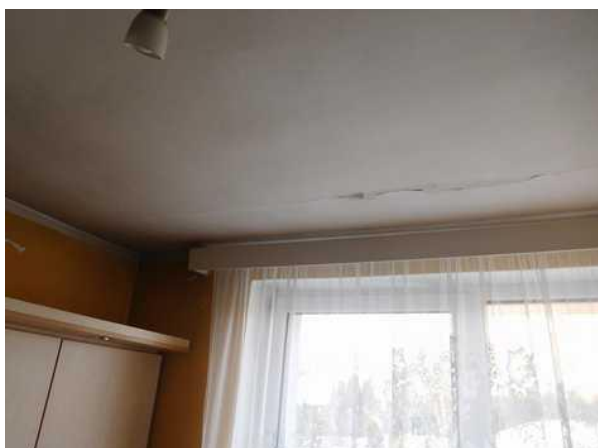
kuchyně a popraskané stropy
