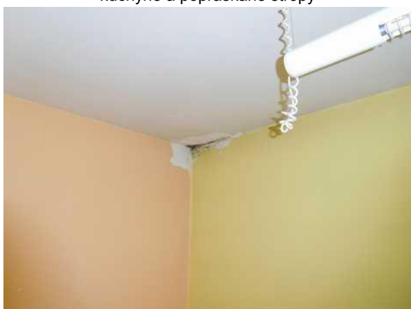
kuchyně a popraskané stropy
