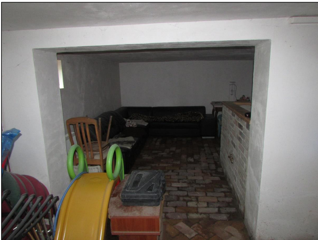
Obr. 4 – Sklepní prostory v 1.PP
