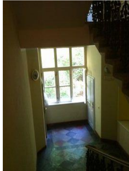
chodba před bytem
