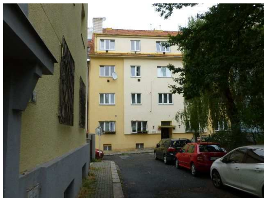
Pohled na čelní trakt č.p. 1158 s nástavbou 4 NP
