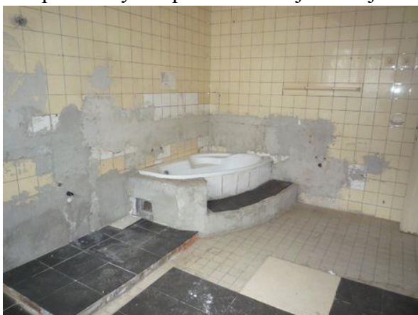
koupelna v bytě 2+1 vedlejšího objektu
