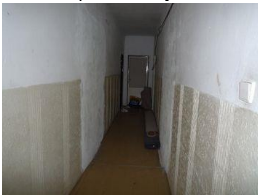
chodba domu čp.18
